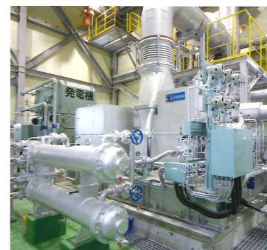
●蒸気タービン発電機 ボイラで発生した蒸気を利用して、最大1900kWの発電をしています。
