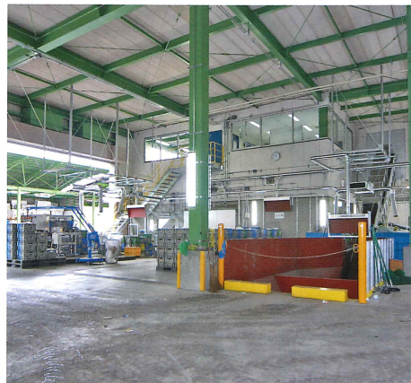
●受入貯留場 リサイクル施設に搬入された缶・金属類やびん類、ペットボトルを受け入れ、それぞれの処理ラインに投入します。
