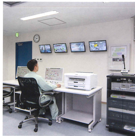
●中央監視室 リサイクル施設内の機器の監視・操作をしています。
